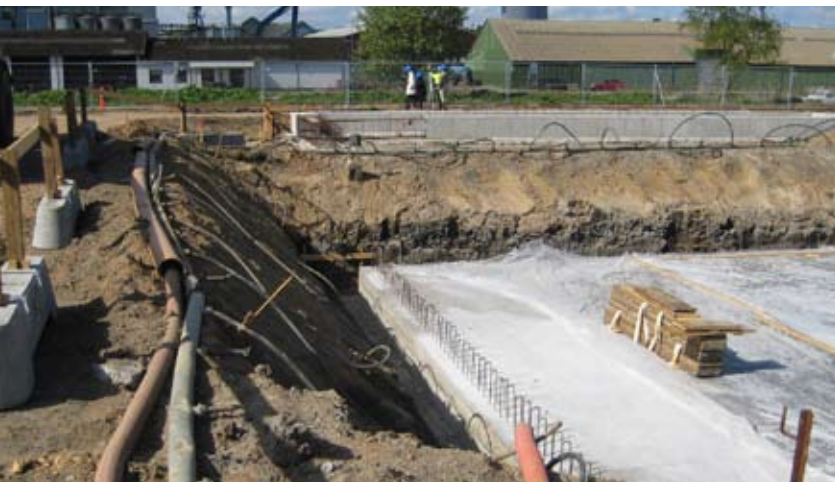
Grundvandssænkning med sugespidsanlæg i Kolding Åpark.
