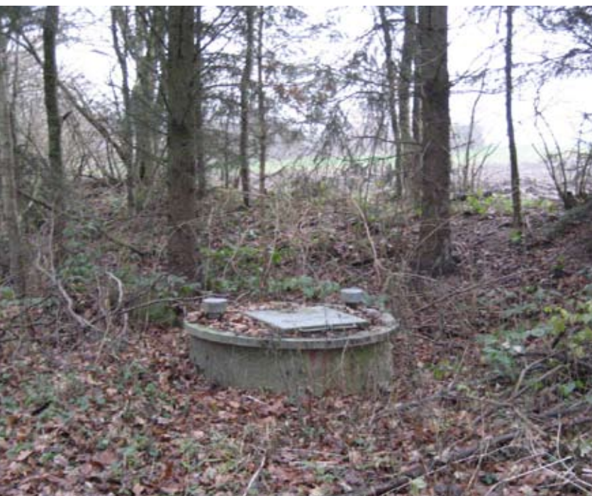
Indvindingsboring med beskyttelseszone – Christiansfeld Vand A/S.
