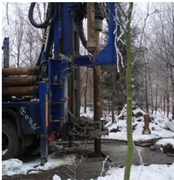
Borerig - etablering af ny boring til Vonsild Vandværk.
