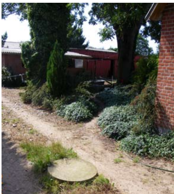
Uheldig placering af husholdningsboring midt i indkørsel.
