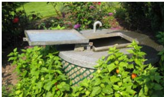
Husholdningsboring placeret i havebed.
