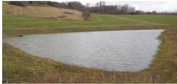
Regnvandsbassin i Kolding Nord.
