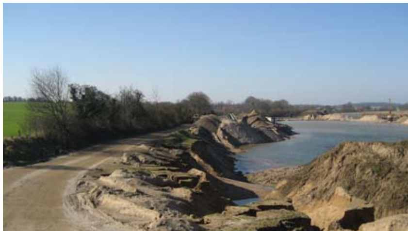
Gravning under grundvandsspejlet i råstofgrav ved Stepping.
